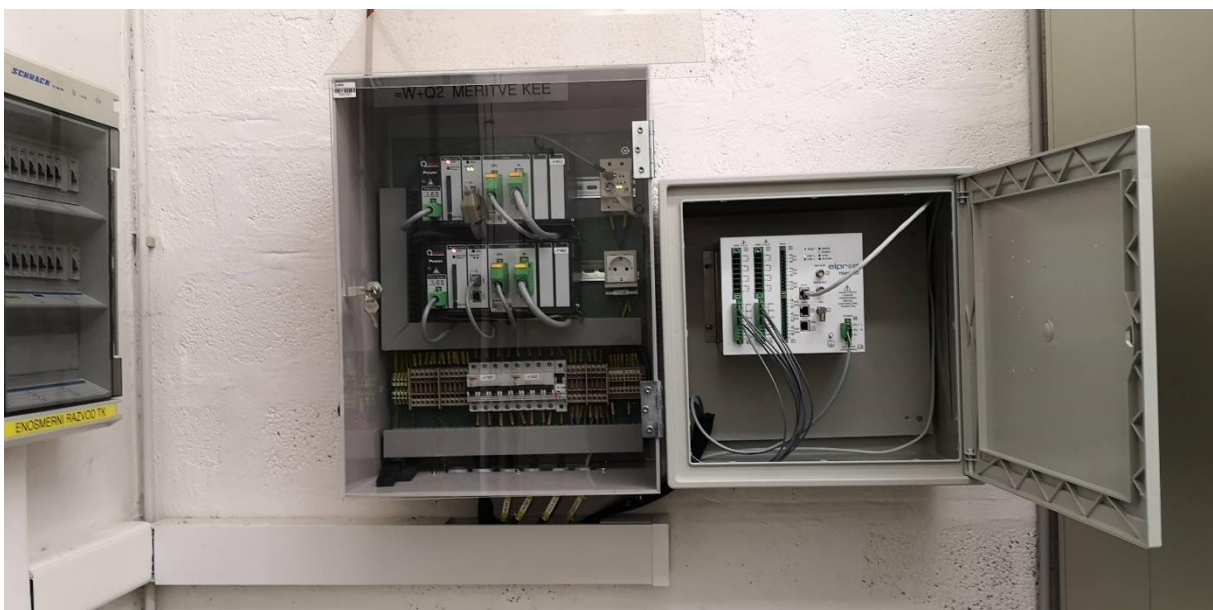
PMU (merilnik faze) nameščen ob omari meritev kakovosti v RP RŽV
