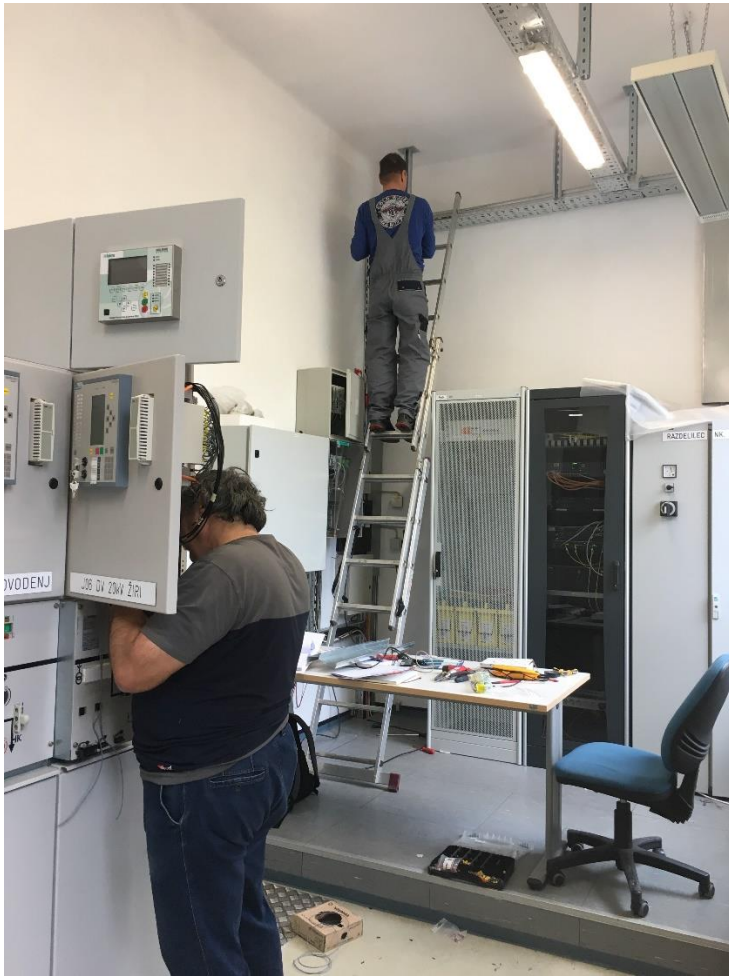
Montaža v RP Sora Fužine
